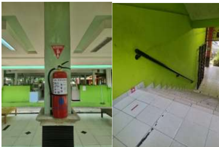
Gambar 3. Pemasangan APAR dan penanda jalur evakuasi
