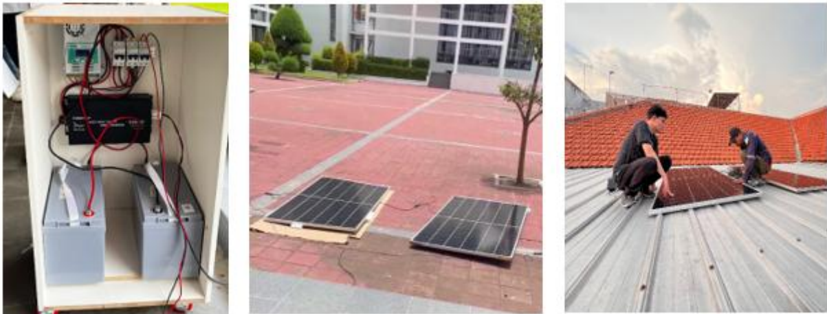
Gambar 5. Pembuatan serta pengujian alat charging station berbasis solar panel
